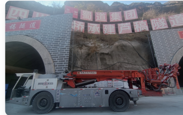
芦稿隧道 Lugao Tunnel
