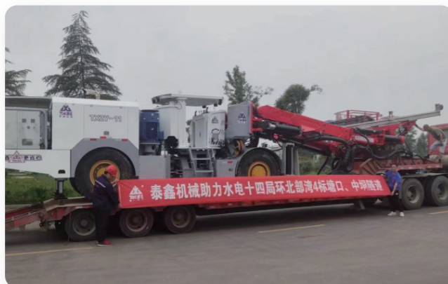
北部湾4标塘口、中垌隧道 Beibu Gulf Section 4 Tangkou Zhongdong Tunnel
